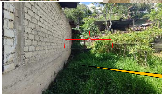
Fig. 04,05,06: Cauce Qda El Sauce. Tramo crítico. Notese quebrada colmatada, incluso se ha reducido y/o estrangulado el ancho de la quebrada, que en una lluvia intensa afectara ambas viviendas existentes en ambos márgenes; que puede afectar una inundación en esta zona.
